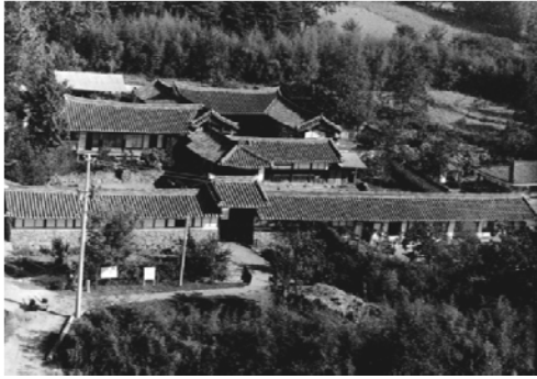
写真1 雲鳥樓の全景
