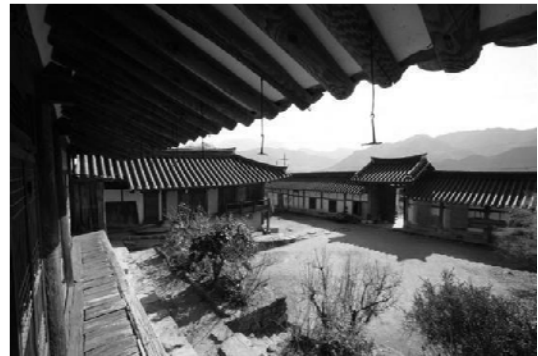
写真1 雲鳥楼の東・西行廊棟 (大舎廊棟からみた行廊棟)
